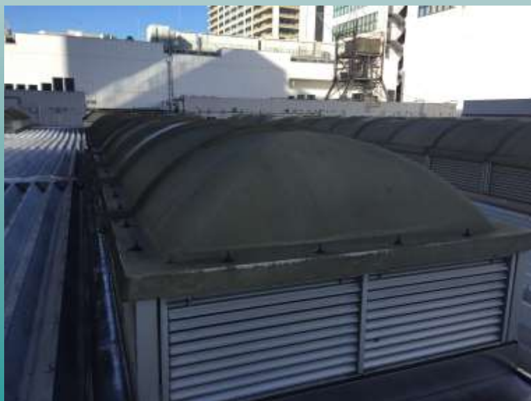
既存FRPドーム
