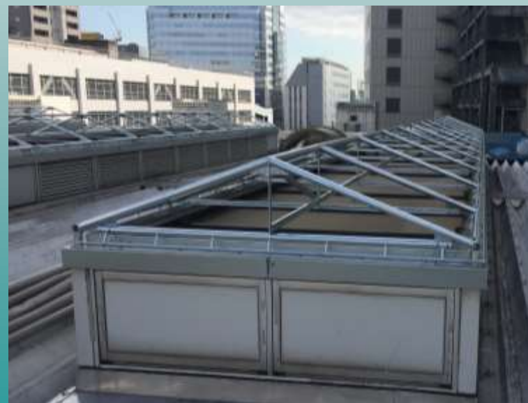
膜屋根下地鉄骨
